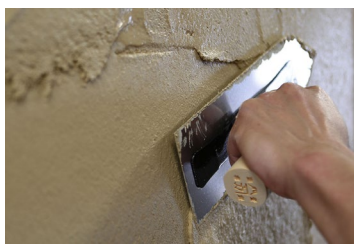
泥灰材料_施工方法
