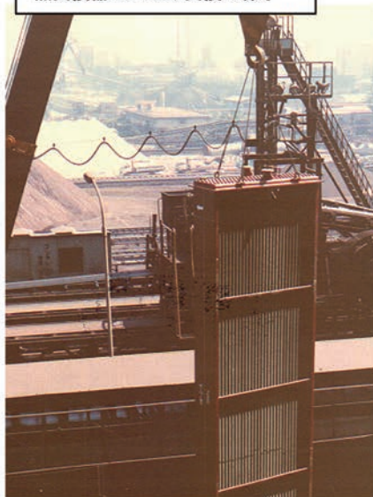
熱交換器エレメント交換の様子
