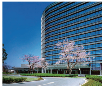
トヨタ自動車事務本館 愛知県 | 事務所 | 2005年 受賞: サステナブル建築賞, 空気調和・衛生工学会賞, グッドデザイン賞
