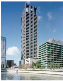
関電ビルディング 大阪府 | 事務所 | 2005年 受賞: 日経ニューオフィス賞, 空気調和・衛生工学会賞, 電気設備学会賞
