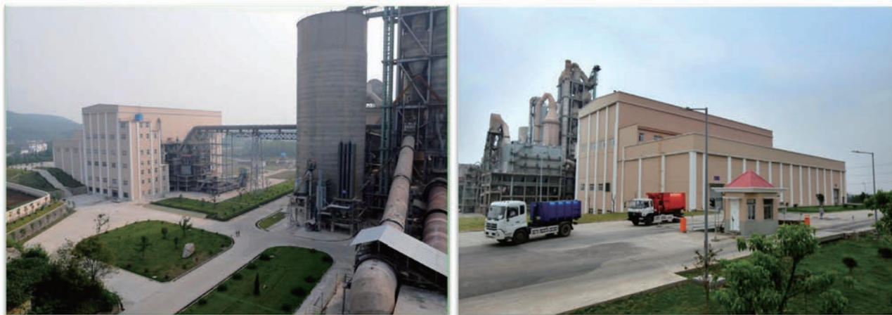
セメントキルンを利用したごみ処理システム (中国 銅陵海螺水泥有限公司)
