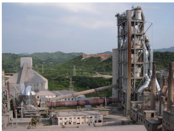
セメント排熱発電設備 (中国 CONCH セメント)
