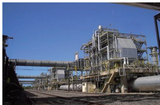
コークス炉排熱発電設備 (ブラジル SOL CST)
