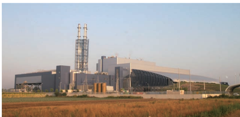
施設外観写真（イタリア ナポリ）（出典：Steinmüller Babcock Environment GmbH 社）
