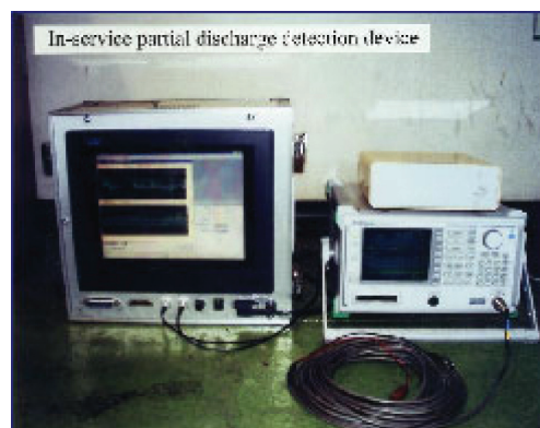
図2 部分放電検出装置運転中
