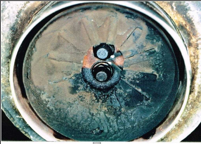
锅炉的扩压器部分（起到形成燃烧空气漩涡、调整火炎的作用） <在添加的条件下，不会形成由碳素引起的网眼堵塞，留下旋涡的痕迹>
